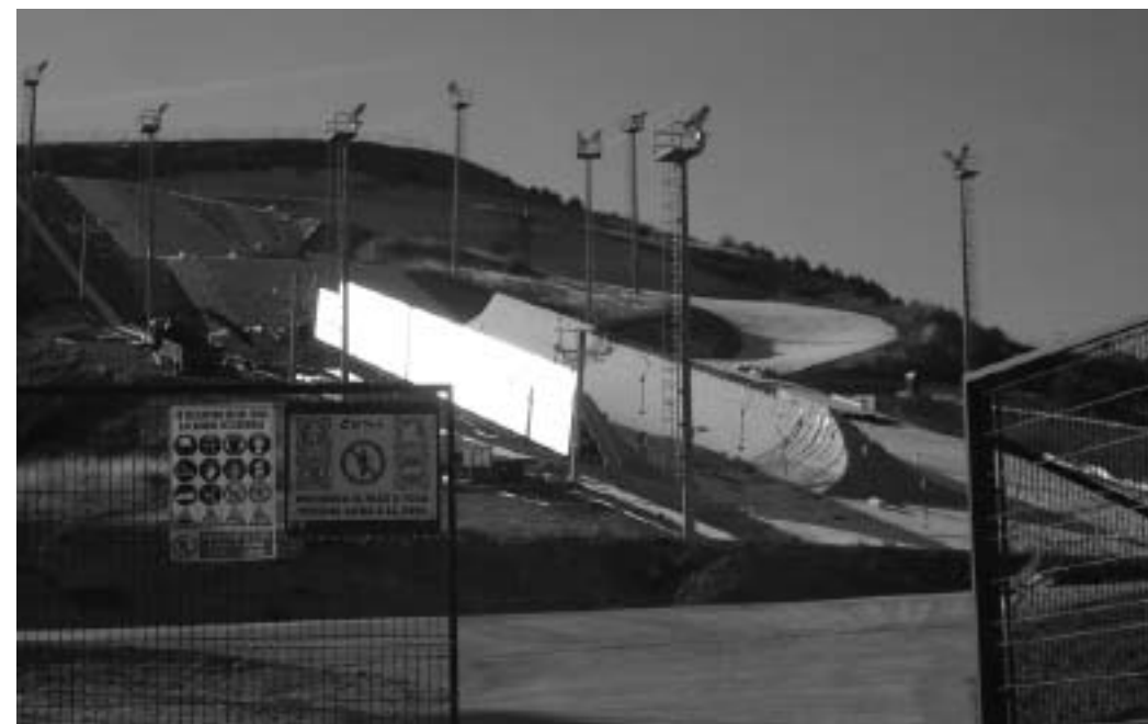
Obras de construcción de Meseta Ski, promovida por la Diputación de Valladolid.
